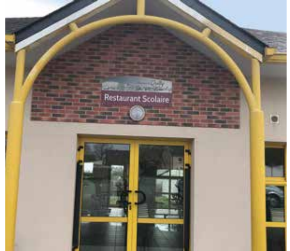
Installation de panneaux signalétiques
