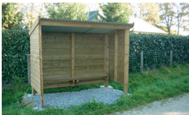
Aubette de transport scolaire au Grand Betz
